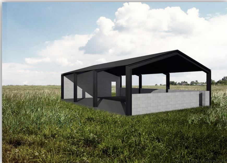
Nos hemos decantado por una construcción de estructura de acero revestida de un material altamente aislante. La cara norte ciega dedicada a las áreas de trabajo y la cara sur completamente acristalada para que entre la luz a raudales y poder disfrutar de las vistas a las montañas.
